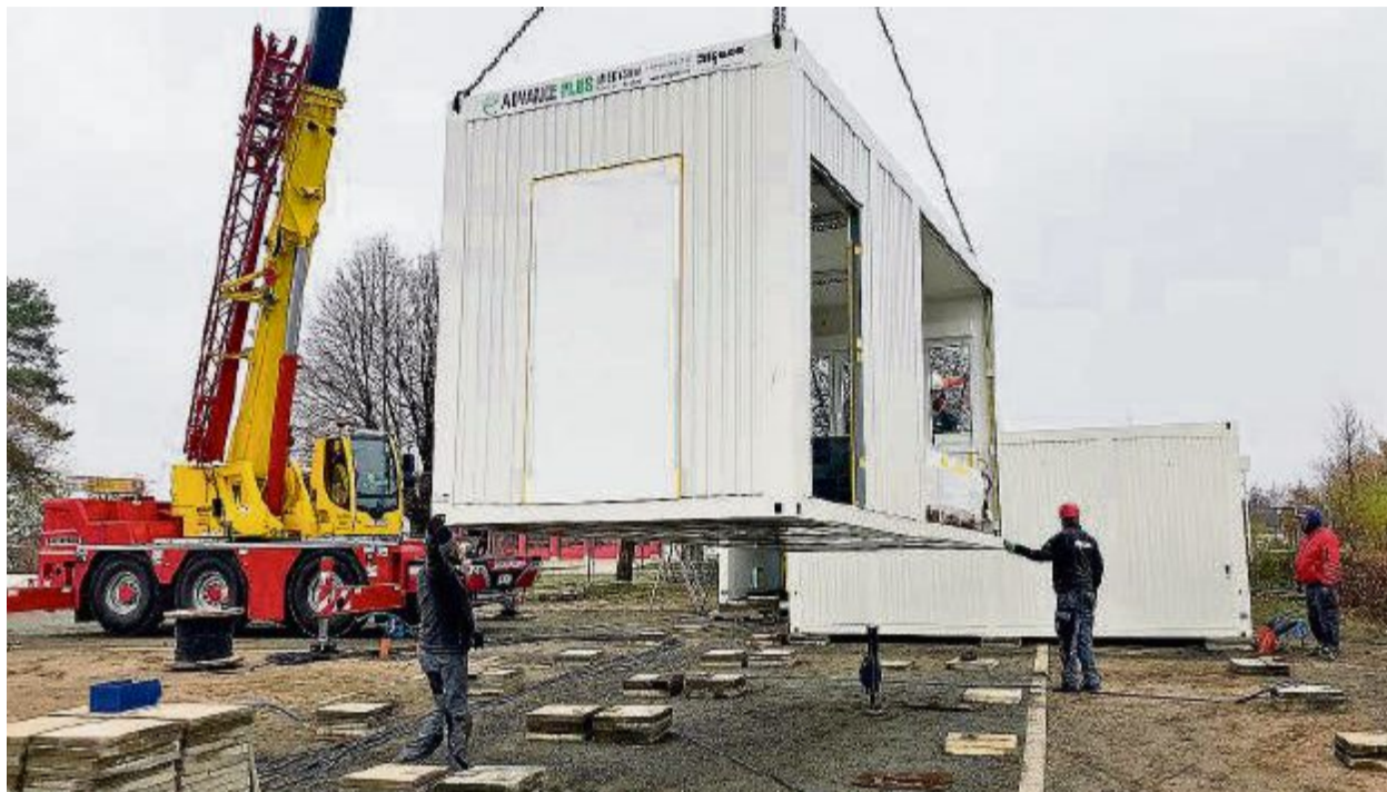
Mitarbeiter des Modulbauers Algeco bauen die ersten Container auf dem Wohnmobilstellplatz auf. Bis heute sollen es 54 sein, die insgesamt 850 Quadratmeter Platz bieten. Zum Vergleich: Die Kita ist knapp 1000 Quadratmeter groß. FOTO: LHT
