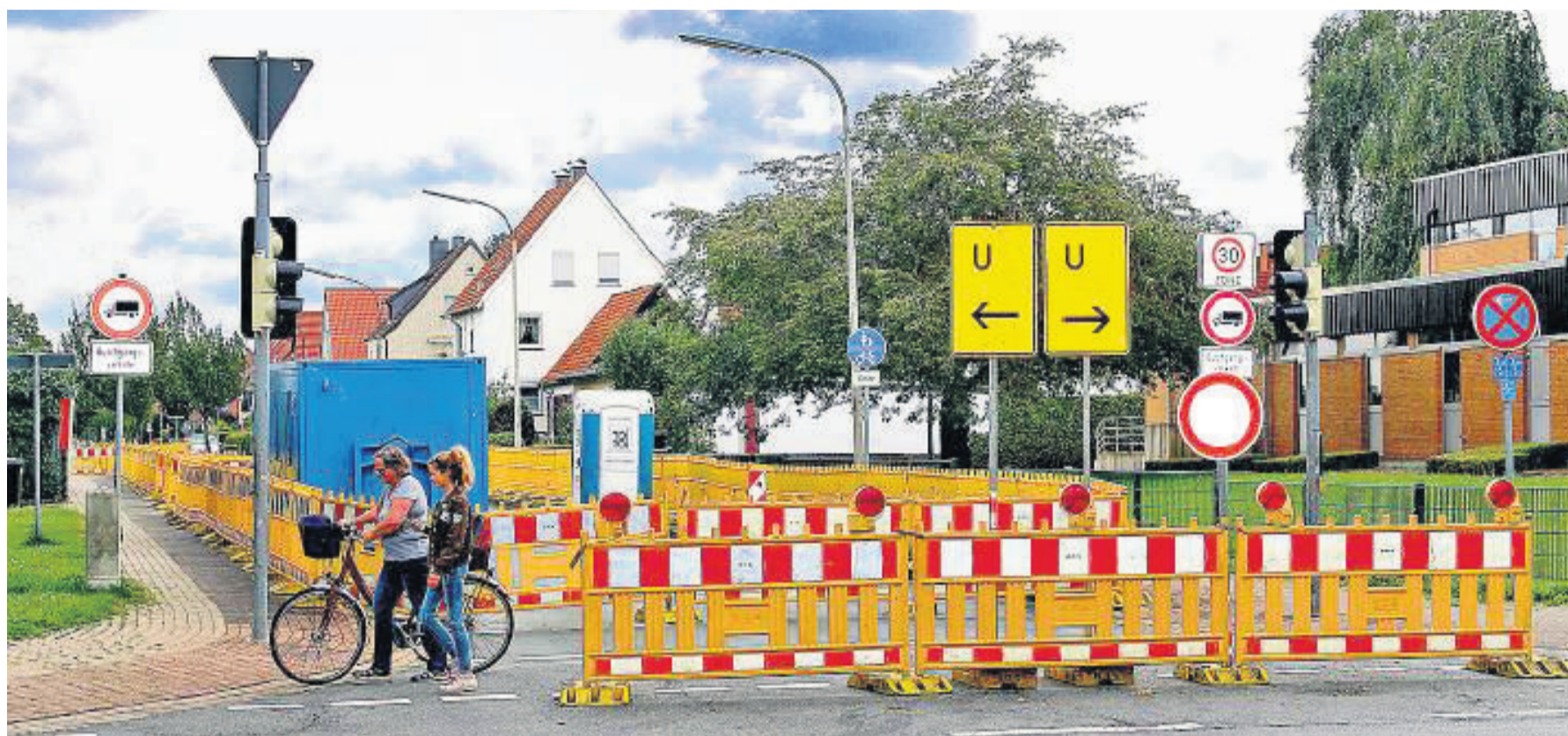
Bereits rechtzeitig vor Beginn der Kanalbauarbeiten ist die Schachtstraße zwischen Jahn- und Luisenstraße gesperrt worden.
