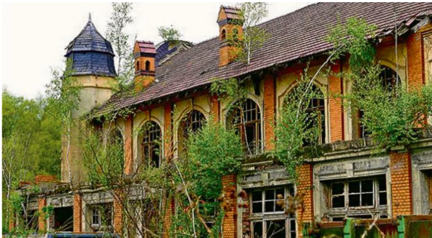
Für die Kohlenkirche gibt es Hoffnung. Das Schicksal des Wasserturms (kleines Bild) ist besiegelt.
