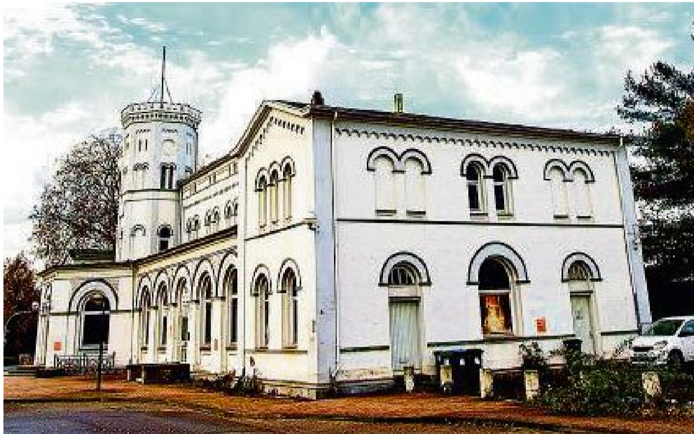
Als schwierig erweist sich die Suche nach Nutzern für das sanierungsbedürftige Bahnhofsgebäude.
