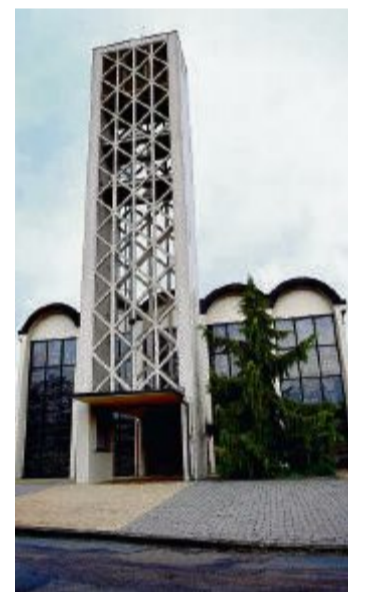
Vor 61 Jahren wurde der Grundstein für die St.-Barbara-Kirche gelegt. FOTO: BAB
