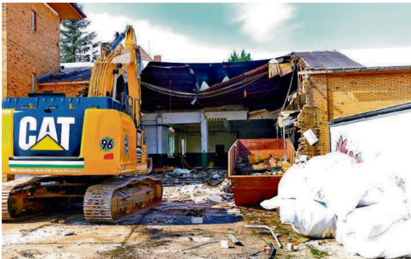
Die Abrissarbeiten an der Gartenstraße haben begonnen.
