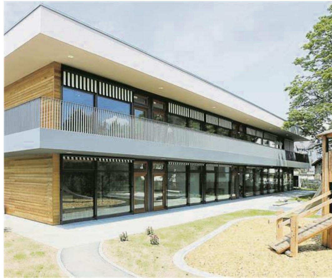
Eine „Modul-Kita“ in Frankfurt am Main – sechs Kitas sind in dieser Art entstanden, wodurch die Stadt mehrere Millionen Euro sparen konnte. Geplant wurden sie vom Architekten Frank Heinen. FOTO: HEINEN
