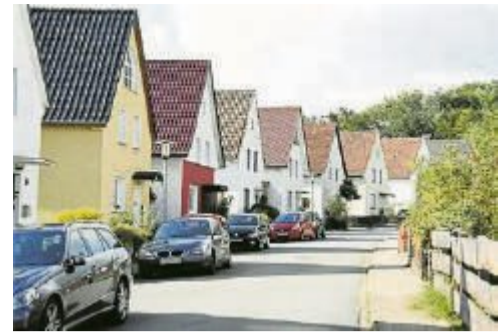
Hier rücken bald die Baufahrzeuge an: Ab 18. September wird die Münchhausenstraße saniert.
