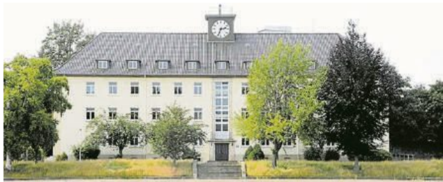
Das Offiziersgebäude ist eines von drei Kasernenbauten, das der British German Club erhalten möchte. FOTO: DANA
